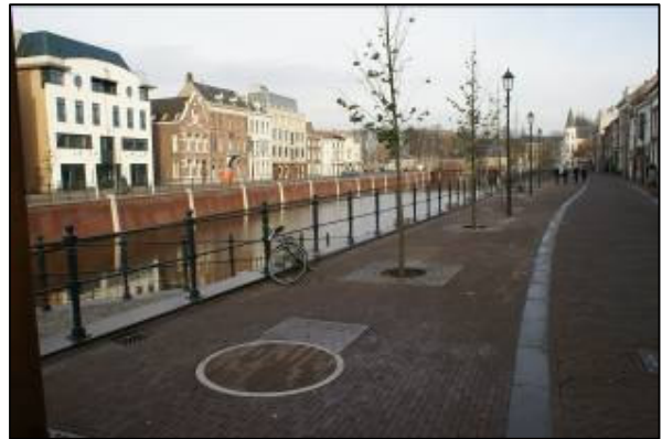
( zelfde UriLift in de straat verzonken met ingelegde deksel)
